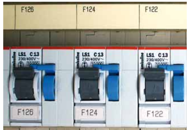
Fig. 11: interruttore magnetotermico
